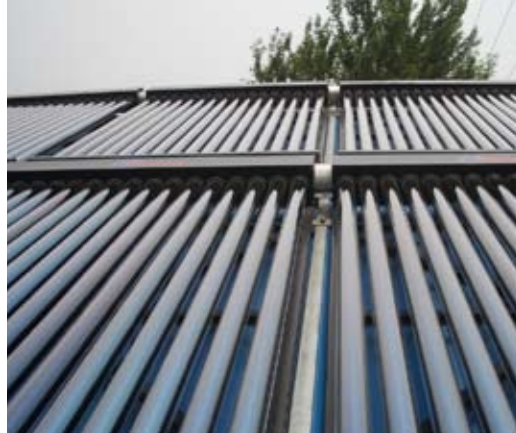
Tyhjöputkitekniikkaan perustuva aurinkokeräin. Kuva: Scandic Sunfi Oy
