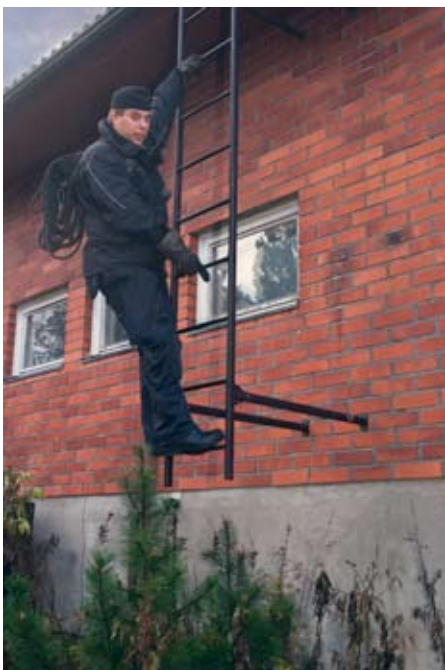
Nuohousvaijerien ja vaijeriharjojen avulla puhdistetaan tulisijan savunkierto. Jäykällä vaijerilla saadaan harjattua savunkierto huolellisesti. Nuohoojamestari Anne Aalto puhdistamassa tulisijaa. Kuvat: Pekka Mäkinen/Nuohousalan Keskusliitto
