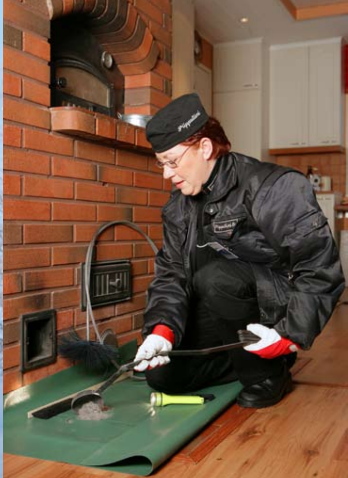
Nuohousvaijerien ja vaijeriharjojen avulla puhdistetaan tulisijan savunkierto. Jäykällä vaijerilla saadaan harjattua savunkierto huolellisesti. Nuohoojamestari Anne Aalto puhdistamassa tulisijaa. Kuvat: Pekka Mäkinen/Nuohousalan Keskusliitto
